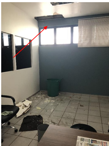
Fotos 03 e 04: Possível que com intensa quantidade de água, causou danos no forro no Gabinete do Secretário de Planejamento.
