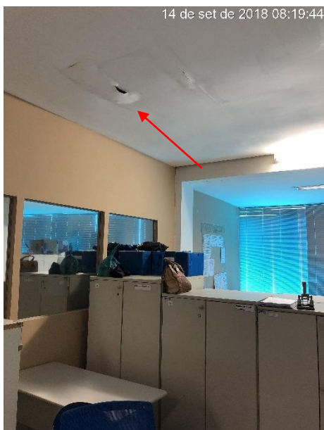
Foto 07: Detalhe do local onde ocorreu goteiras na teira no Setor de Recursos Humanos.
