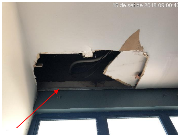
Fotos 03 e 04: Possível que com intensa quantidade de água, causou danos no forro no Gabinete do Secretário de Planejamento.
