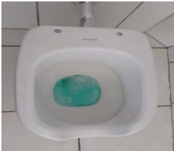
Imagem nº01 – Higienização dos sanitários pela equipe de limpeza e manutenção da escola, ressaltando que a unidade está em recesso escolar nesse período.
