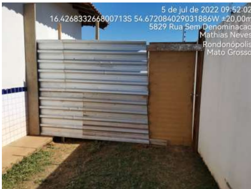
Imagem nº03 – Porta de acesso do canteiro de obras para unidade escolar.
